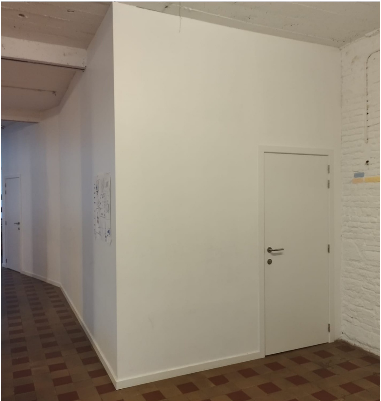
Travaux du corridor au 1er étage
